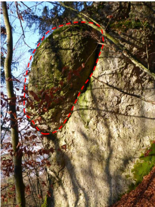
Abb. 4: beinahe vollständig vom Muttergestein getrennte Felskugel, die lediglich durch ein brüchiges Auflager noch vor Ort gehalten wird, Foto: 13.12.2017
